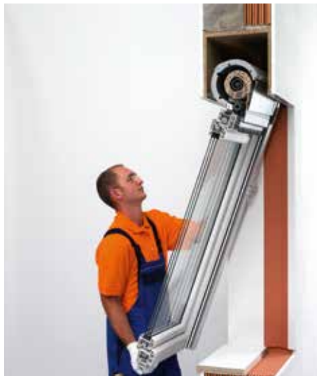
Fenster mit TERMO einsetzen.
