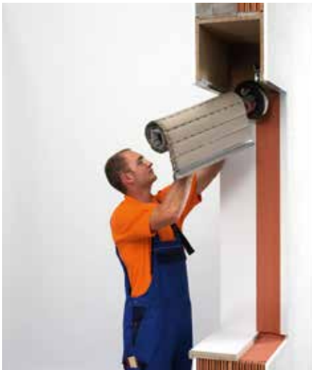
Alten Rollladen aus dem Kasten entfernen.
